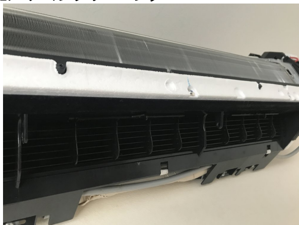
1.エアコンクリーニング
