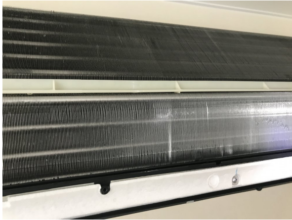
1.エアコンクリーニング
